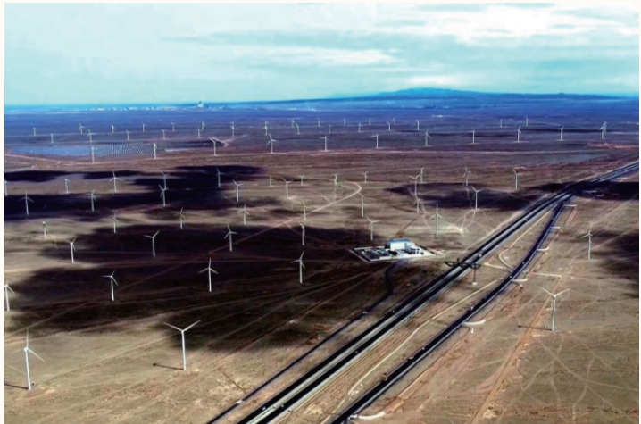
图 4.6 中核甘肃玉门风电、光伏和光热一体化发电项目
