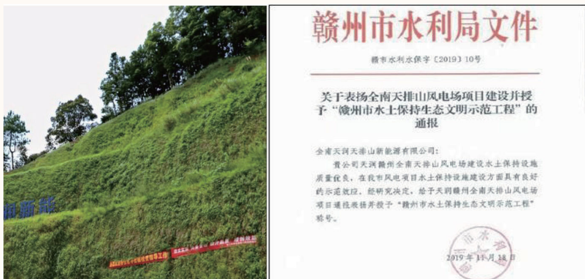
图 6.11 赣州全南天排山风电场项目现场（摄于 2020 年 8 月）
