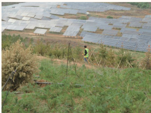
a 内蒙神东布尔台采煤沉陷区光伏电站
