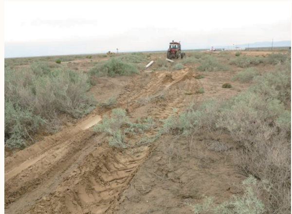
b 场站外葱郁的植被及施工机械碾压
