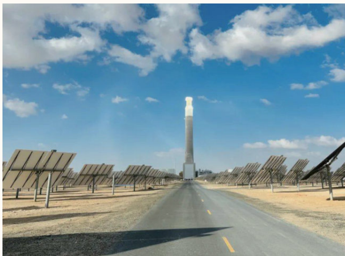
图 4.9 迪拜 700 兆瓦光热 +250 兆瓦光伏太阳能电站项目
