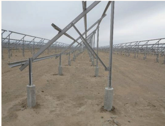
a 甘肃武威某在建项目地表为不毛之地
