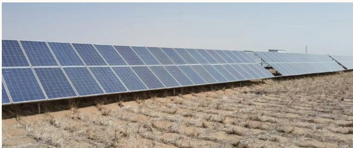
图 6.5 光伏电站的草方格治沙工程措施（摄于 2022 年 3 月）
