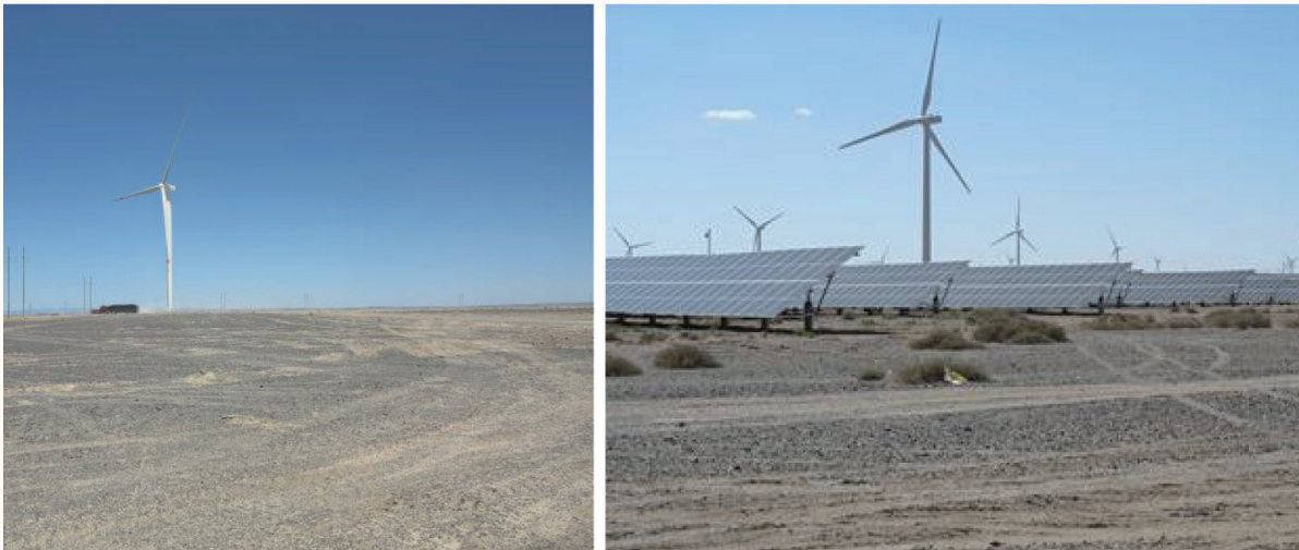
图 6.10 瓜州某风电场与风光同场电站的植被状况对比
