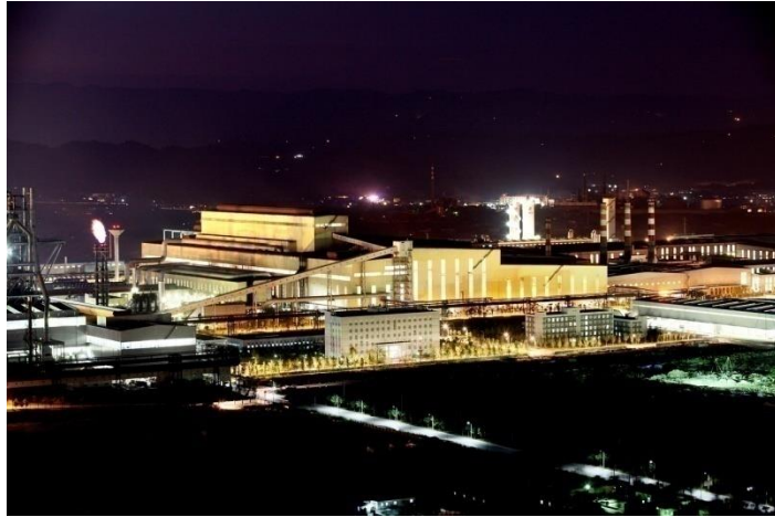
图 2-1 新重钢生态工业园区夜景
