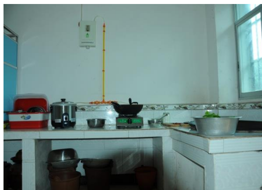
(配备沼气能源的厨房)
