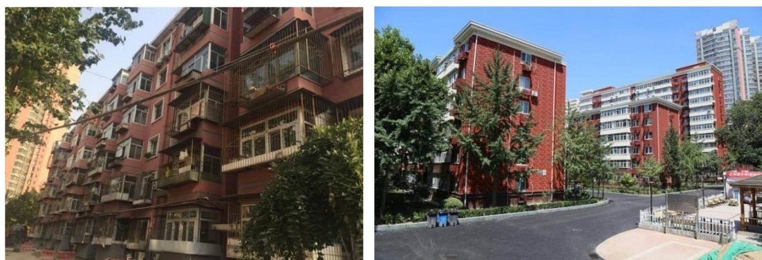
图 3-4 丰台区莲花池西里 6 号院整治改造前后实景
