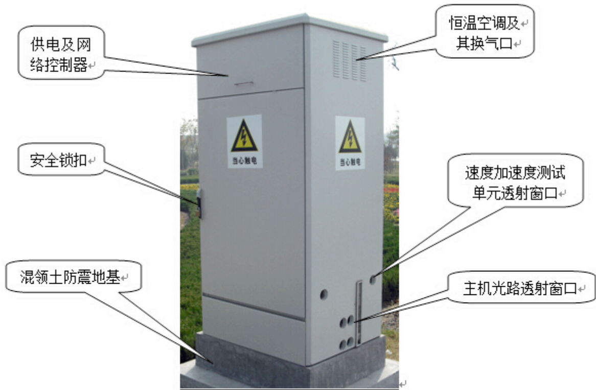
图 3.13 主机机柜图示
