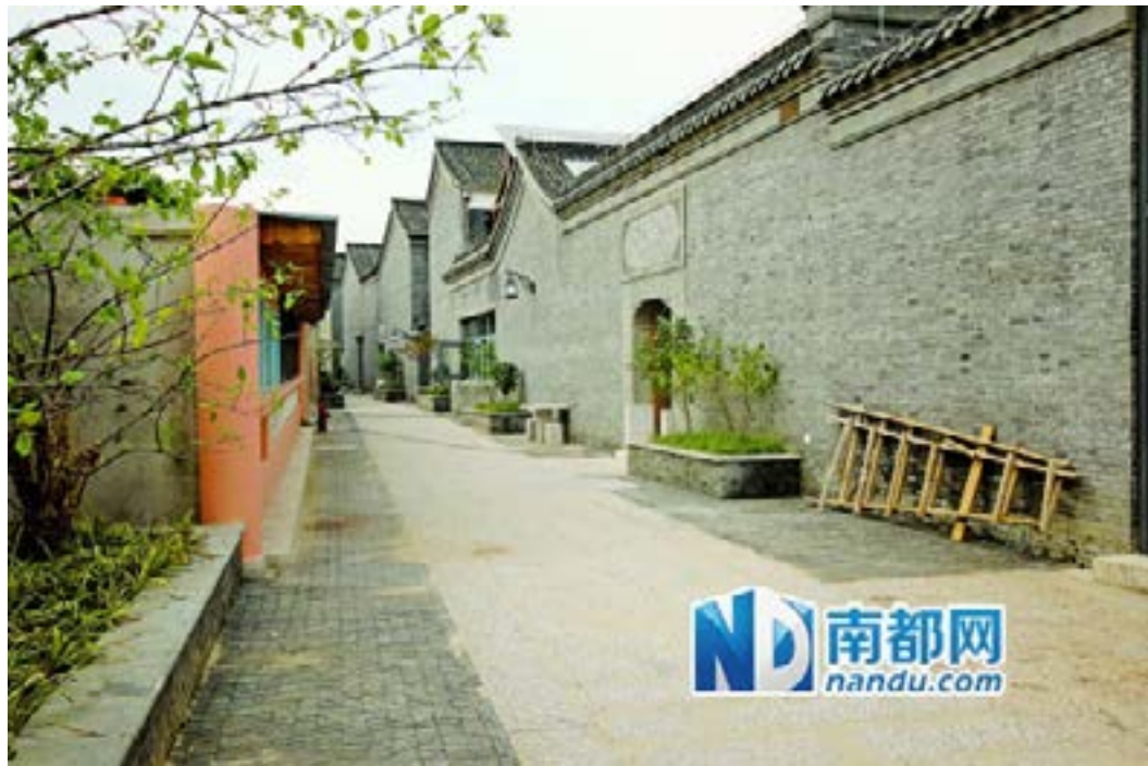
图 15 废弃地已改造成的综合低碳社区
