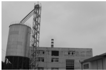
工业用户：乳山染整工业园供热站
