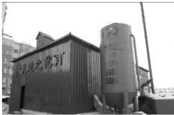
长春陶瓷厂住宅移动式供热站
