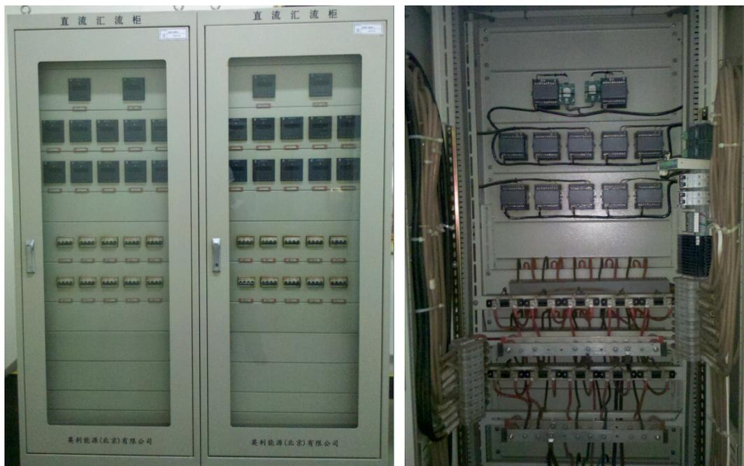
图 22 直流控制柜及内部接线
