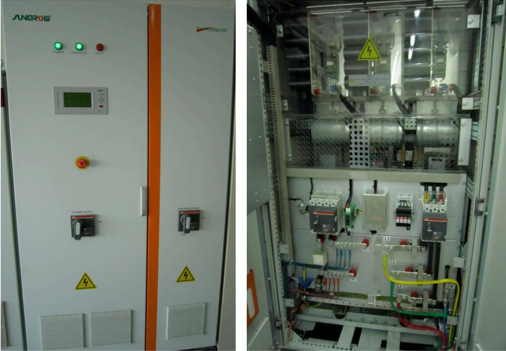
图 26 光伏逆变器及内部接线
