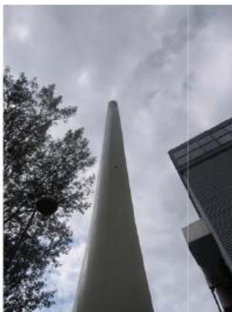
图 Vestforbrænding 垃圾焚烧厂烟囱外部图
