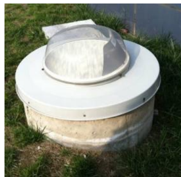
东部行政区能源站光导管照明
