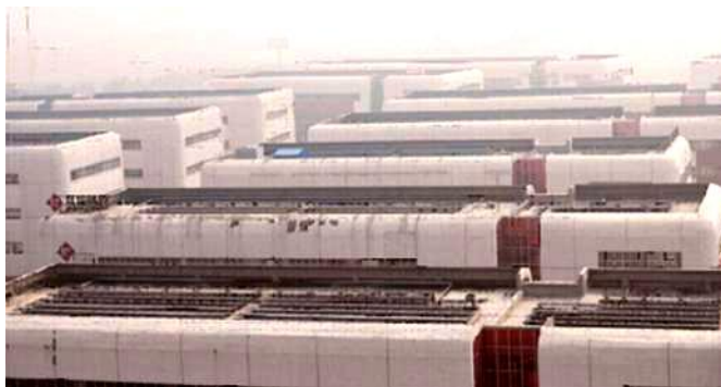
标准厂房太阳能光伏项目
