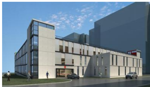
CMC 综合能源集中供应中心 (位于立体停车楼下方)
