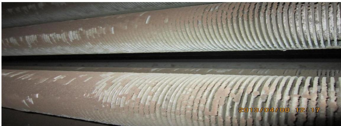
下图为裂解炉吹灰后对流段炉管的照片：
