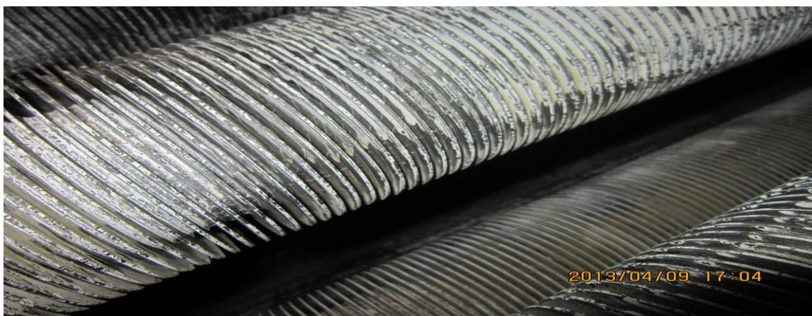
经过对 8 台裂解炉对流段的吹灰工作，超高压蒸汽温度从前期的 470℃左右
