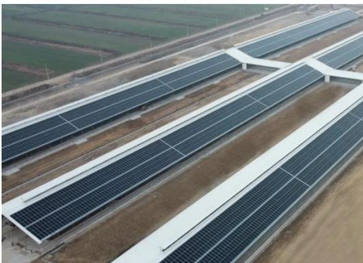
图 7-14 牧场棚舍顶铺设光伏组件
