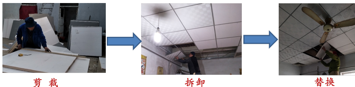
图 5-17 已有吊顶更换保温材料流程
