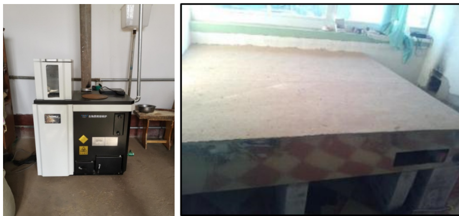
图 5-27 生物质取暖炉-对流炕系统
