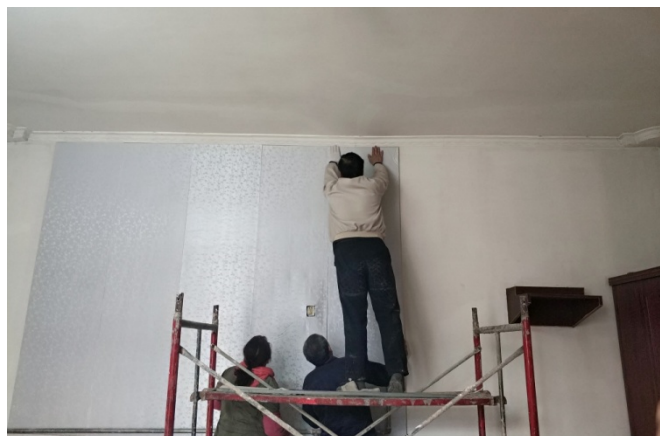
图 5-19 外墙内保温技术施工
