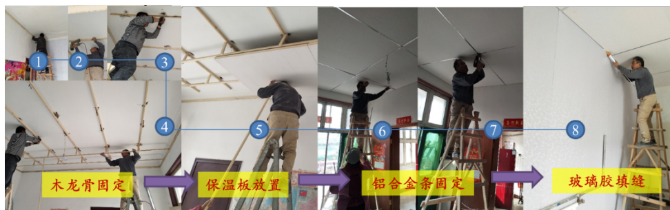
图 5-18 新增自保温吊顶施工流程
