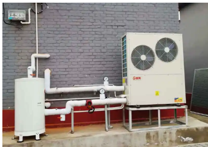
图 5-24 低温空气源热泵热水机系统
