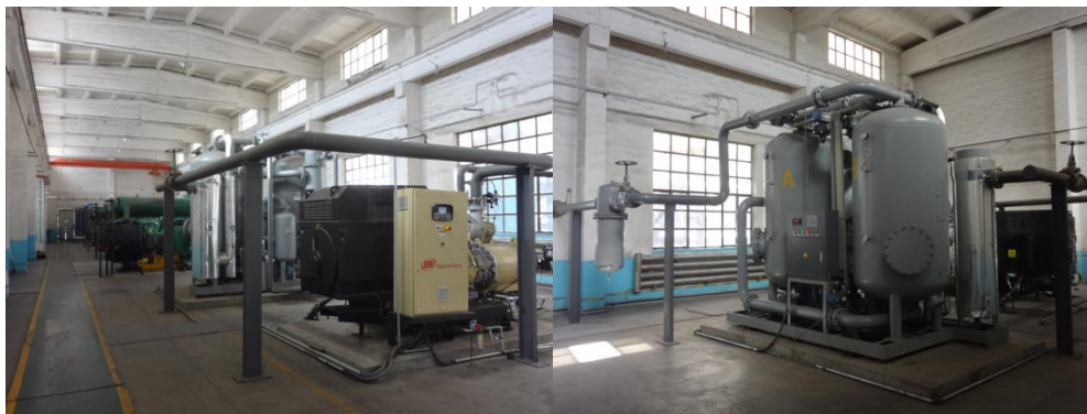
系统改造现场图
