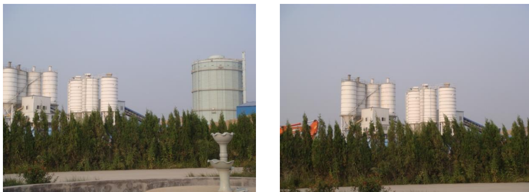
图 3-5 青岛绿帆再生建材有限公司现场图
