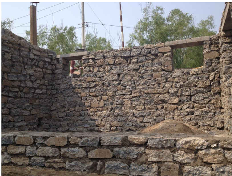
图 5-1 北京房山区北甘池村居民利用建筑垃圾再生产品修建的房屋
