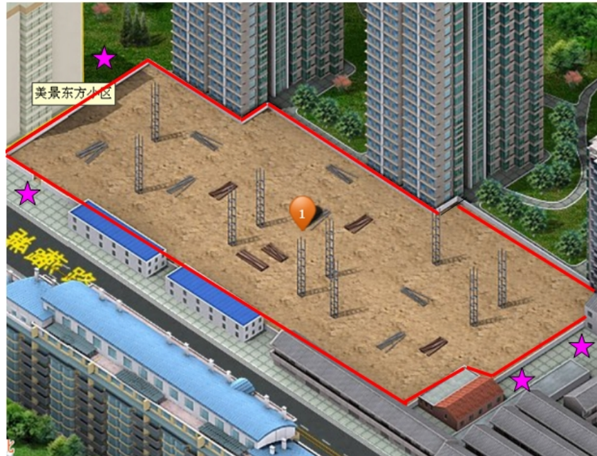
图5-6 北京市朝阳区弘燕路美景东方小区施工工地
