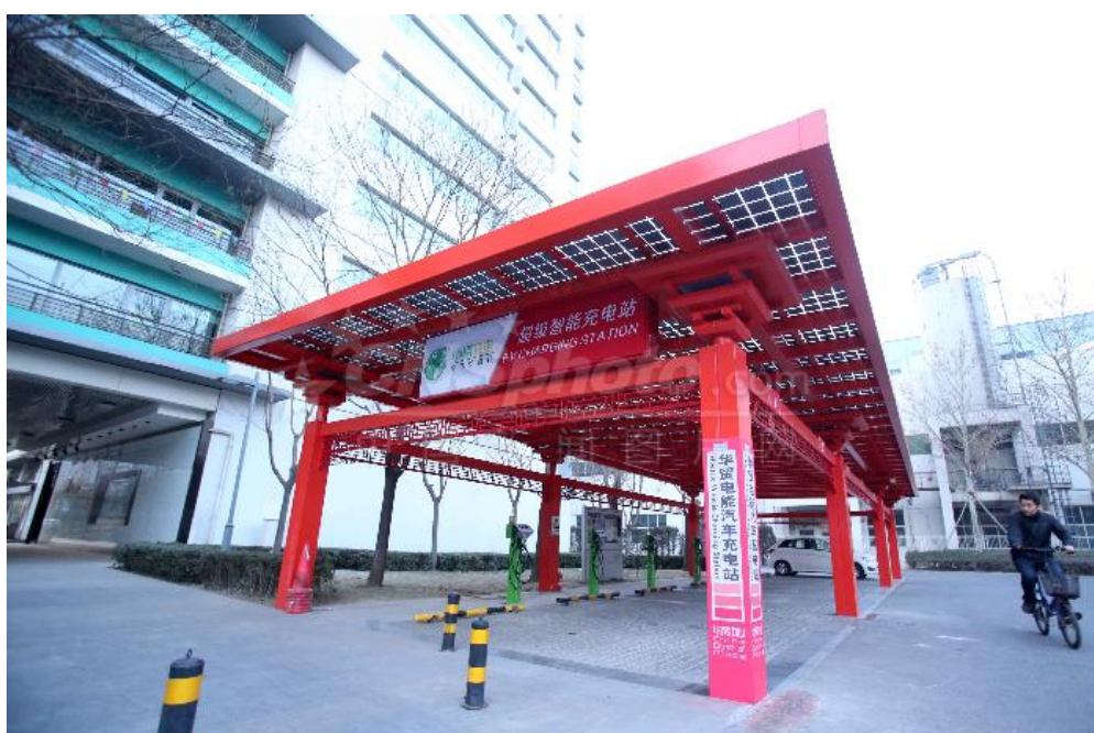
图 1-2 北京华贸中心光伏充电站
