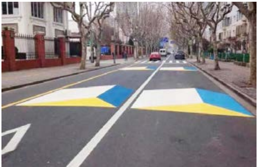
市政道路上的立体 减速彩色标线
