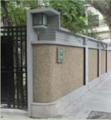
沿街围墙修缮与改造
