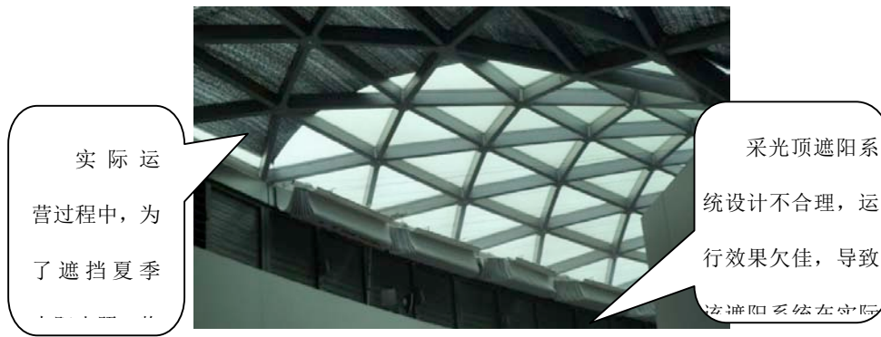
图 4-15 采光顶遮阳问题
