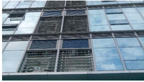
图 4-17 外墙内嵌的太阳能集热器面板
