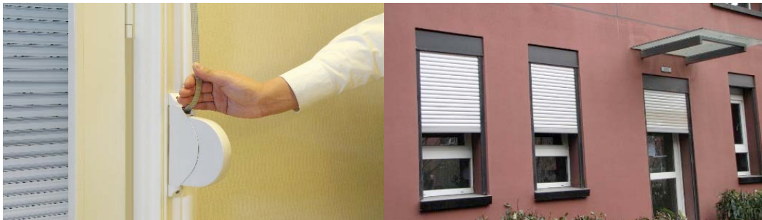
图 4-2 手动开启外遮阳系统与外遮阳部分开启实景图
