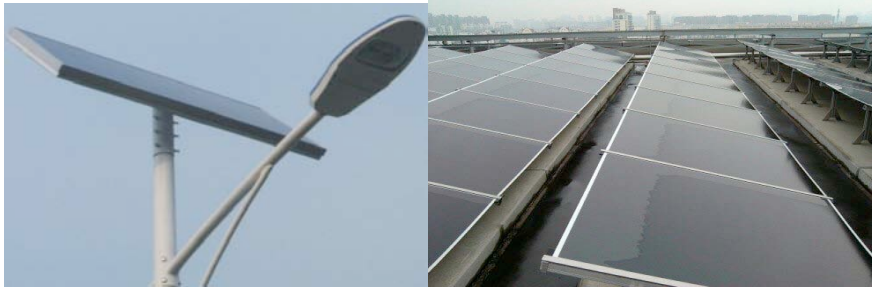
图 4-13 太阳能光电建筑一体化和太阳能路灯
