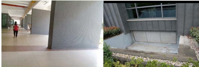
图 4-28 底层架空和自然通风通道设计
