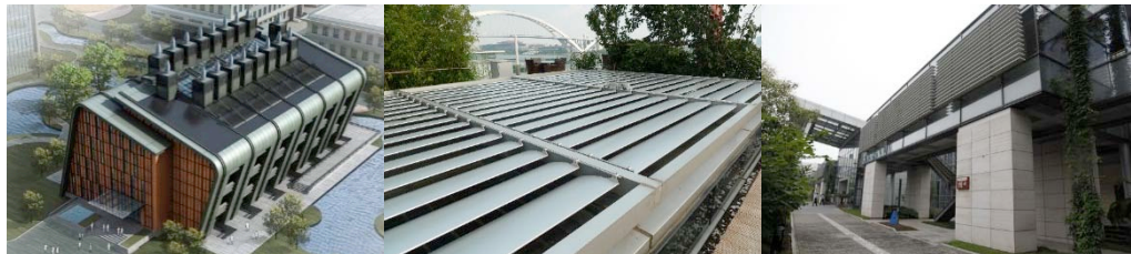
图 4-29 建筑自遮阳、屋顶和里面遮阳设计
