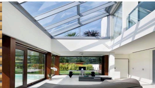
图 4-34 采光顶导致眩光严重
