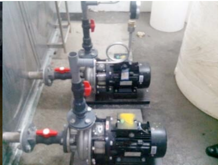
图 4-24 闲置的雨水收集设备图
