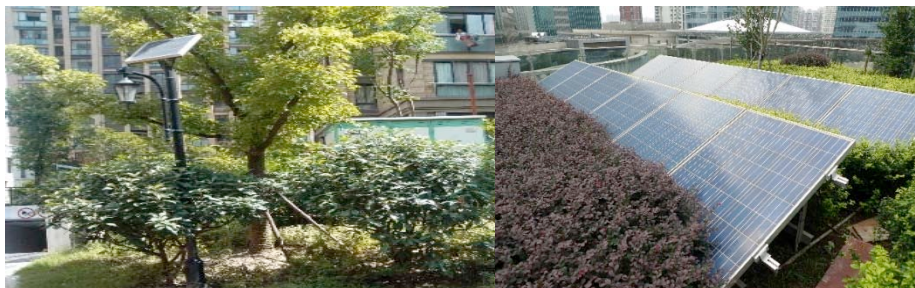
图 4-16 景观植被遮挡了太阳能电池方阵
