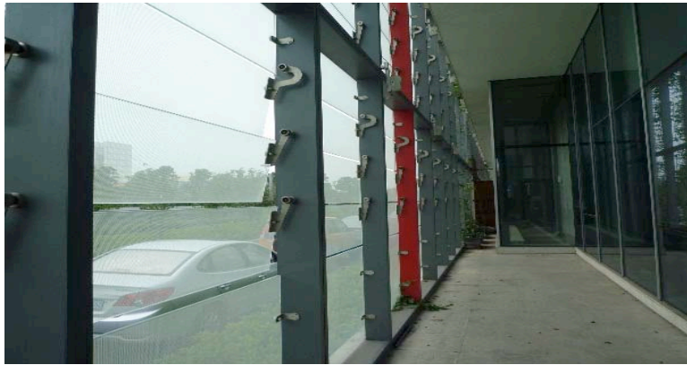
图 4-4 遮阳系统无法正常使用
