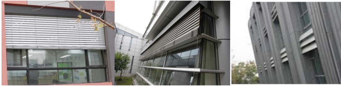
图 4-1 调研项目外立面各式各样的遮阳系统
