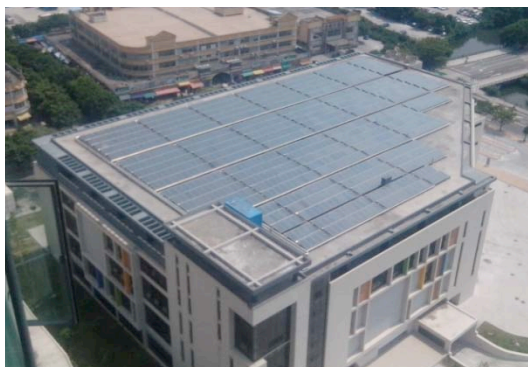
图 4-11 屋顶太阳能热水系统
